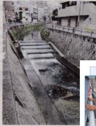
●階段式の魚道の段差を改善する工事が施された津門川（西宮市で）。●調査で捕獲されたアコヤカワムツ＝山本さん提供
